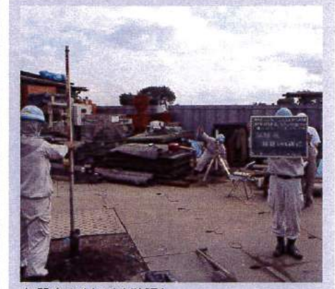
打設完了(レベル確認)
