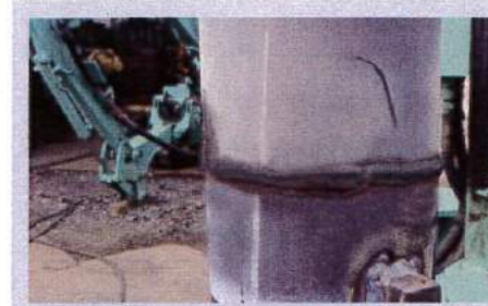
継手溶接完了
