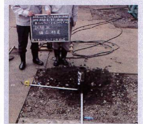
打設完了(偏芯確認)
