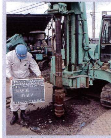
打設完了(打ち止め)
