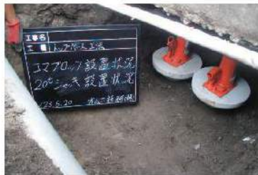
コマ型ブロックを設置して建物をジャッキアップ
