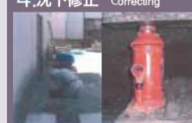
鋼管杭の上にジャッキをセットし基礎ごと上げ家屋の沈下部分を修正します。
