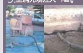
基礎のベースと鋼管杭の頭部周辺にセメントミルクを充填します。
